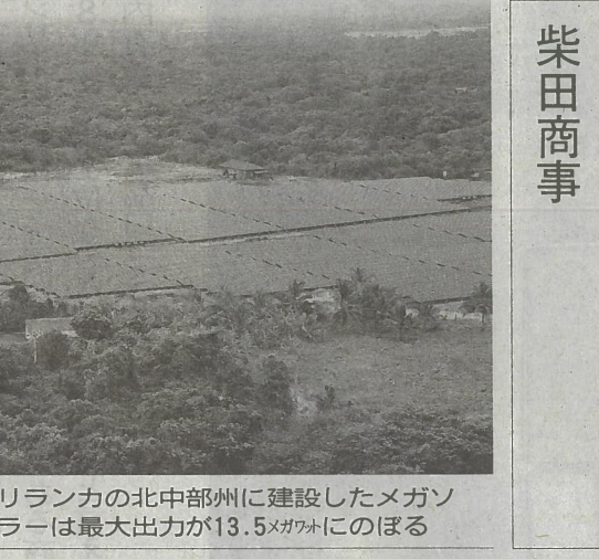
スリランカの北中部州に建設したメガソーラーは最大出力が13.5メガワットのほ
