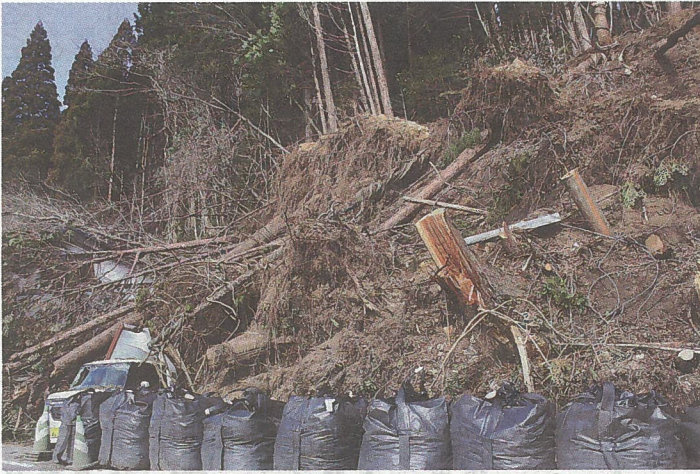
斜面が崩壊、立木がなぎ倒されている山林も多数
