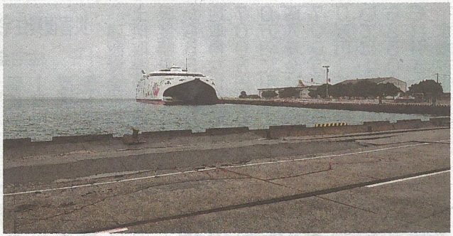
耐震補強が施された岸壁には、防衛省が災害支援のために派遣した「ナッチャンworld」が停泊していた(2月20日撮影)
