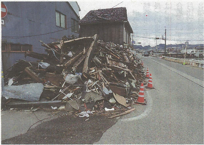
松本町で倒壊した住宅。一時は瓦礫が道路をふさいでいた
