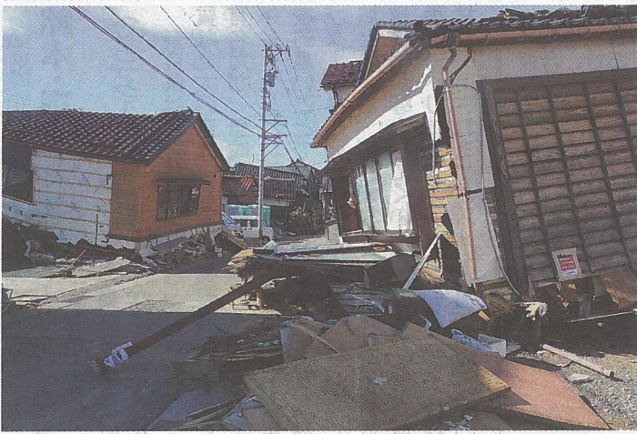
市街地では1階部分が押しつぶされた家屋が目立つ
