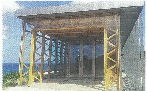
自社開発の圧密L型材を供給した「潮騒レストラン」(石川県珠洲市)
