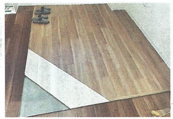
ナオスシートを施工した事例(同社商品ショールーム)
