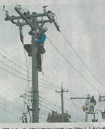
電線の復旧訓練に取り組む参加者。一金沢市の田上変電所
