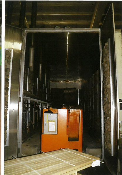
▲フルタニランバー(鋼製「Woodbe」)を一部導入し、自社に合ったスケジュールを調整中だ
