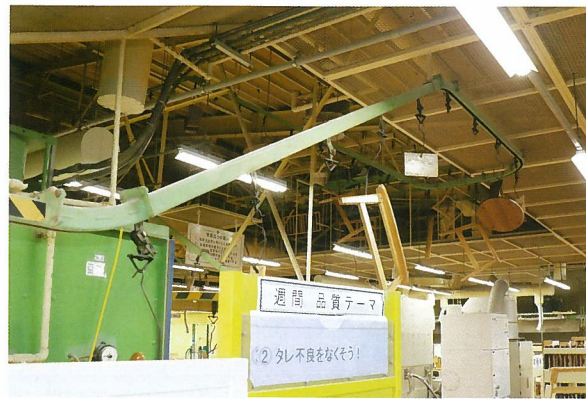
▲塗装後の乾燥室は工場の上部。ラインが上へ向かう様子が見えるだろうか
